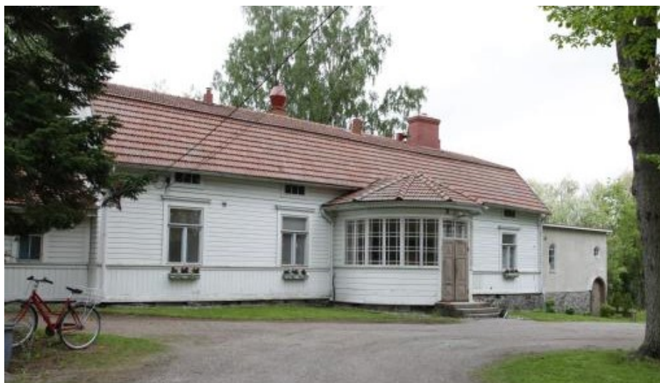
Pappilan päärakennus. Kuva: Tuusulan kunta.
